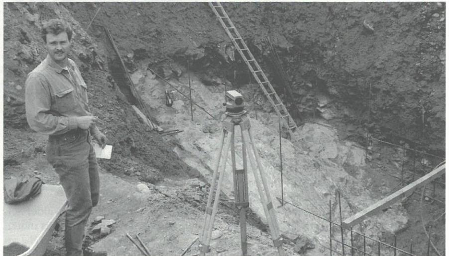
**Der Abstand zwischen Fundament und Seilabspannung muß genau stimmen:** Ein Zivilgeometer achtet darauf, daß eine Toleranz von plus/minus 1,5 cm nicht überschritten wird.
